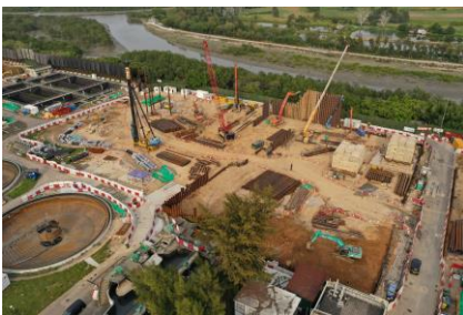
鋼板樁擋土工程 Sheetpiling works
